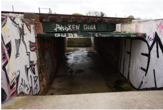
Figura 14-Passagem inferior à linha férrea existente, a poente do apeadeiro
