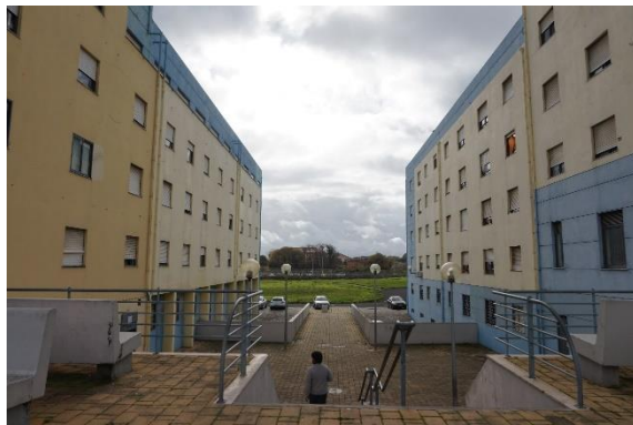
Figura 10 - Acesso Pedonal à Rua Portela.
