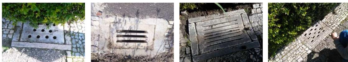
3.5 Lajeados de pedra – recuperação. A degradação de algumas superfícies originais revestidas com lajes de calcário bujardado, particularmente nas rampas do lado norte, partidas aparentemente por acção da passagem de veículos, leva a que se proceda à sua substituição, operação que exige particular cuidado na selecção da pedra e na reprodução do acabamento das superfícies à vista.
