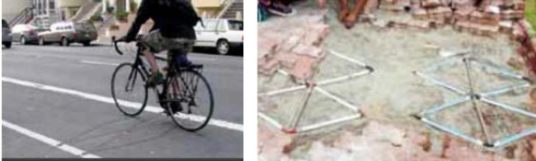
Ilustração 2 - Sensores de detecção de Bicicletas
