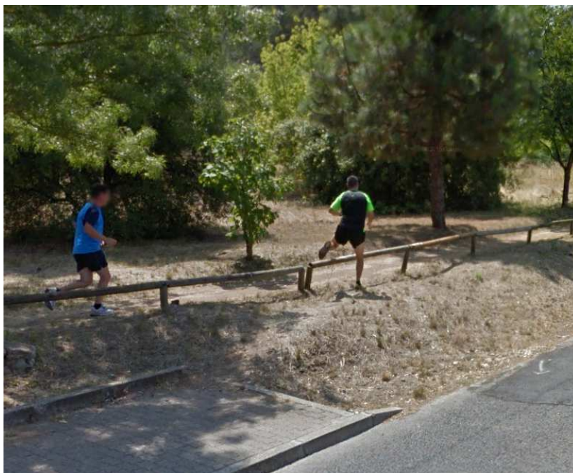
Figura 3| Estrada do Outeiro - Barreira de madeira existente
