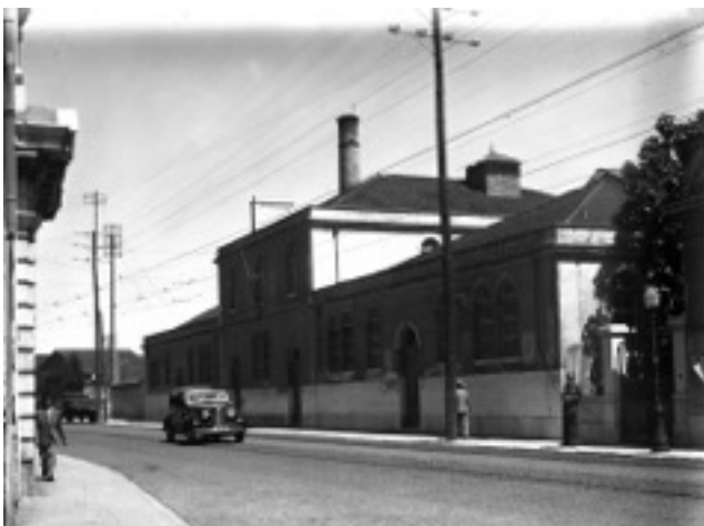
Fig. 5 - Edifício da Cozinha Económica
