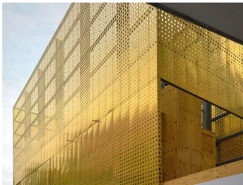
**Figura 8** - Ampliação nascente da Estação Campo Grande. Painéis metálicos de fachada
