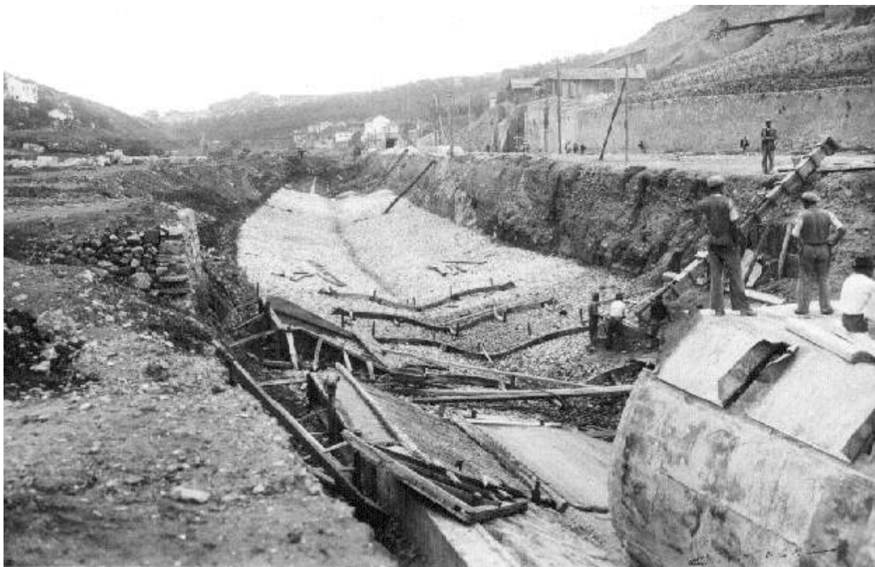
Vale Alcântara – construção do caneiro - 1945 - Arquivo Fotográfico Municipal
