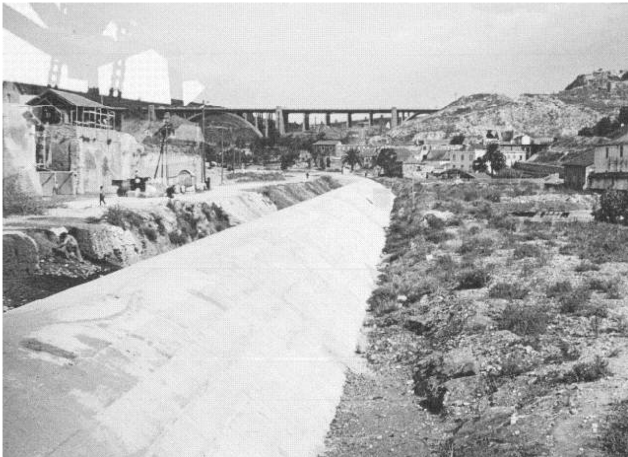
Vale Alcântara – construção do caneiro - 1945 - Arquivo Fotográfico Municipal
