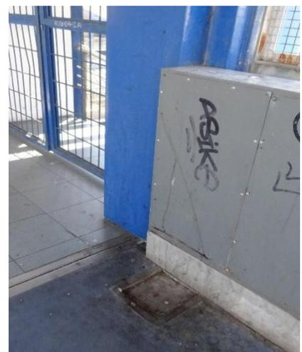
**Quadro da Passagem Superior (Q7) a remover e caixa de pavimento a ampliar para aprox. 35x35cm**
