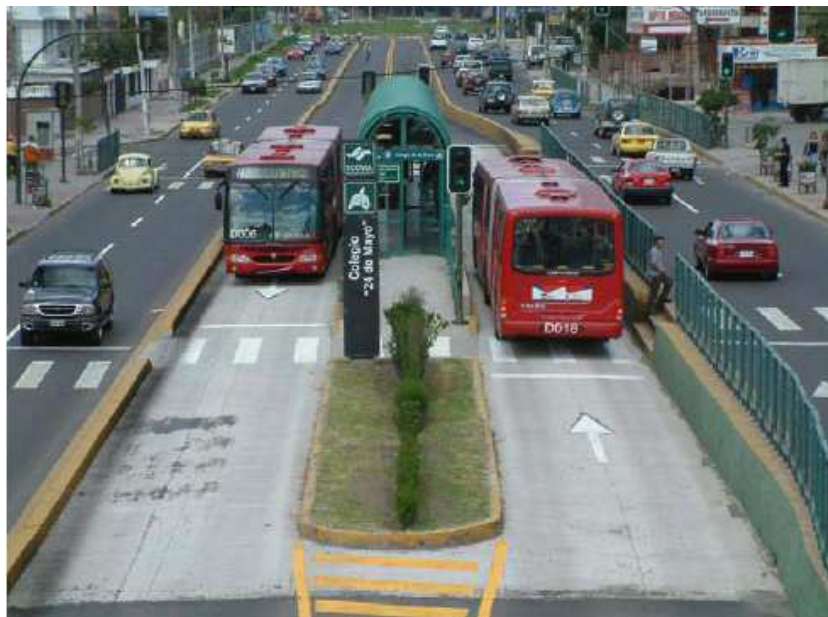
Figura 34 – Plataforma central no corredor Ecovia em Quito (Wright e Hook, 2007)
