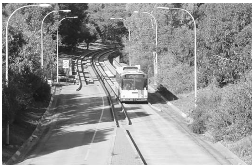
Figura 8 – BRT de Adelaide: zona de entrada e saída no canal guiado (Philips, 2006)
