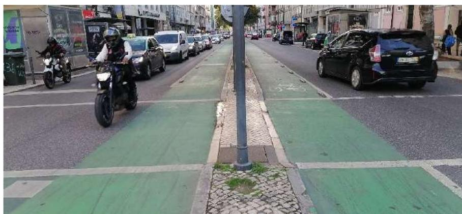
Fig. 111 – Refúgios com dimensões inadequadas
