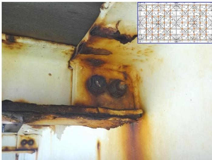
**Figura 14 – Pormenor de uma ligação do tipo 5.**
