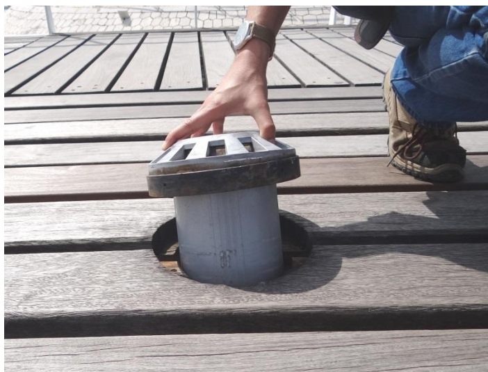
Figura 18 – Pormenor dos focos de iluminação.
