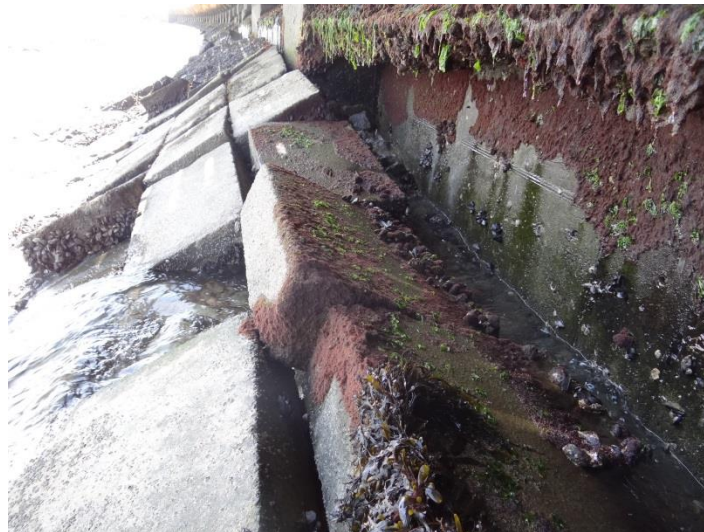
Figura 6 – Pormenor da face exterior do dique, entre os maciços 29 e 30.
