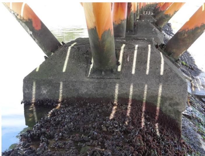
Figura 7 – Vista de um dos maciços de apoio da estrutura.
