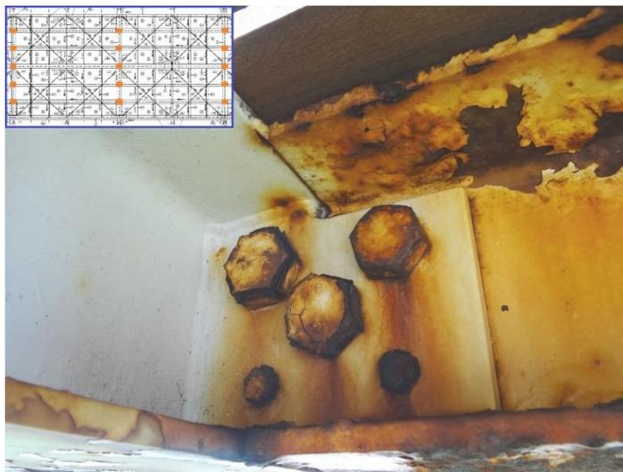
**Figura 12 – Pormenor de uma ligação do tipo 3.**
