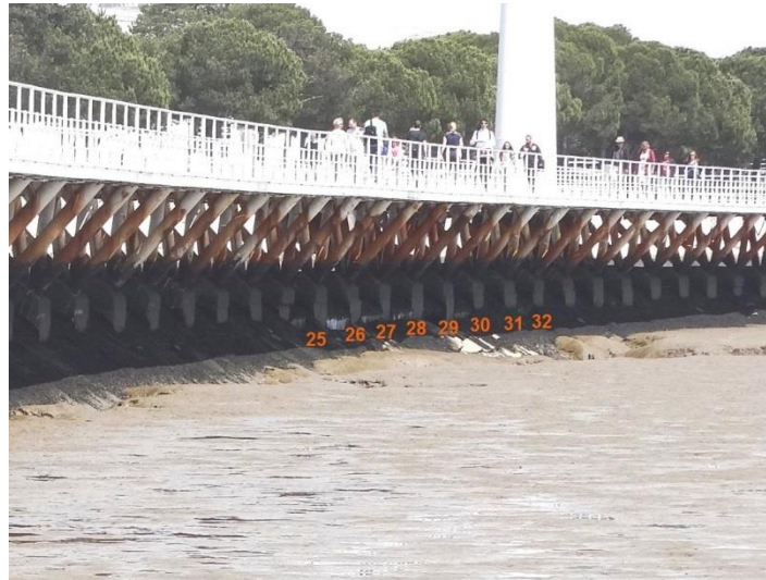
Figura 5 – Vista da face exterior do dique, entre os maciços 25 e 32.
