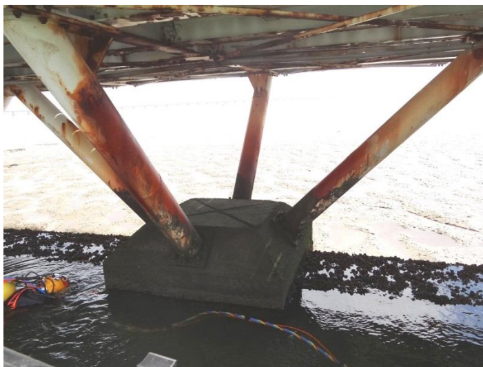
Figura 8 – Vista dos perfis tubulares de apoio da estrutura.
