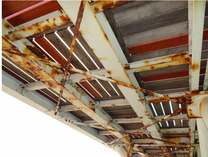
Figura 9 – Vista inferior do tabuleiro metálico.
