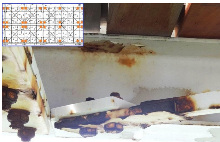
Figura 14 – Pormenor de uma ligação do tipo 5.
