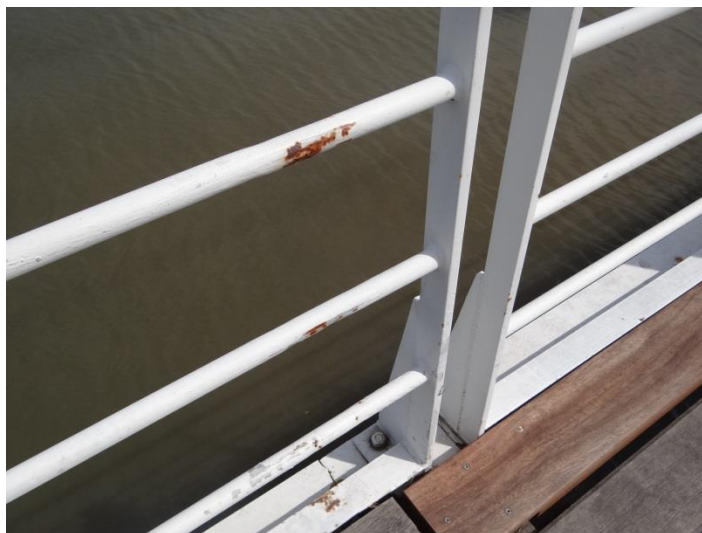
Figura 17 – Pormenor dos guarda-corpos.
