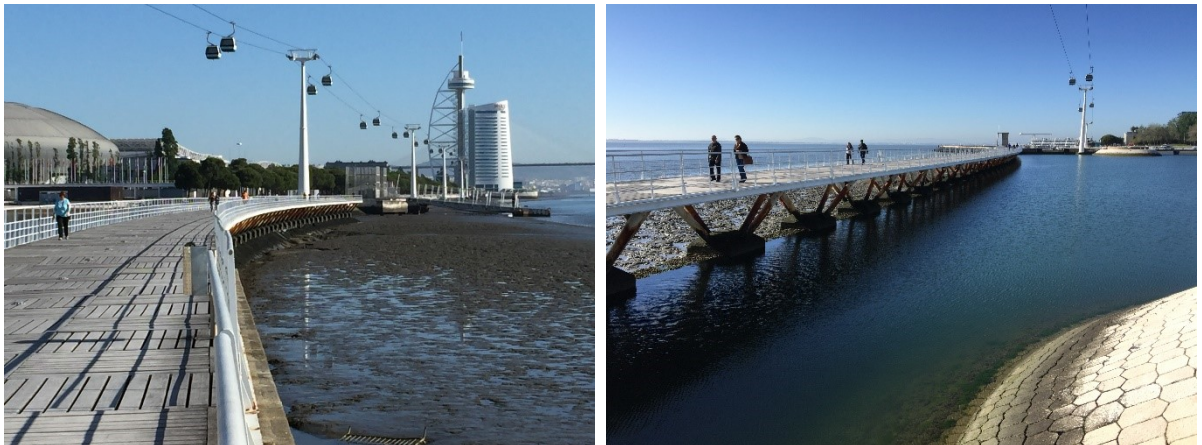
Figura 1.2 – Imagens gerais do passadiço (vistas sul-norte e norte-sul)
