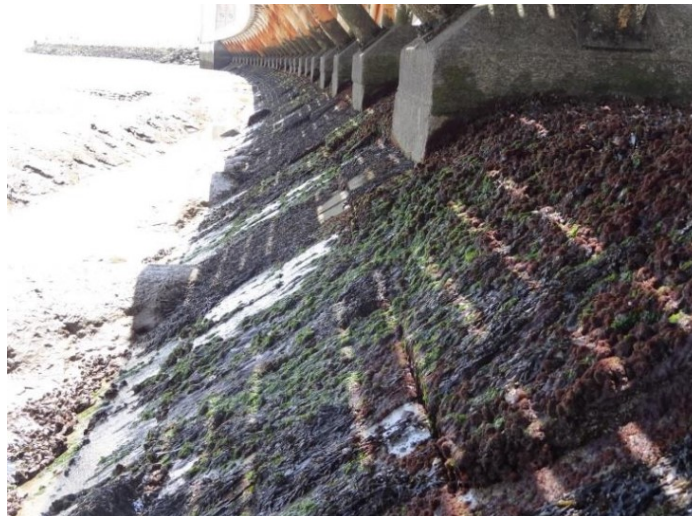
Figura 2.1 – Face exterior do dique em zona sem danos relevantes (fonte: BETAR)
