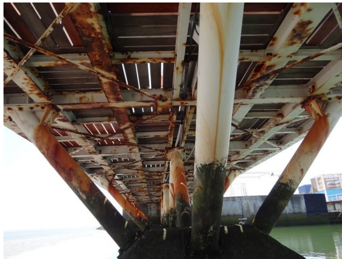
Figura 2.5 – Vista geral da estrutura metálica do passadiço (fonte: Betar)
