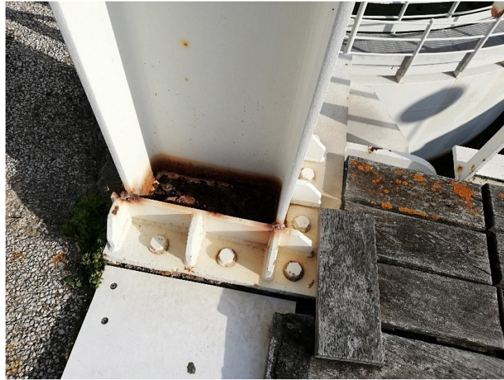
Figura 7.7 – Base dos pilares da ponte móvel
