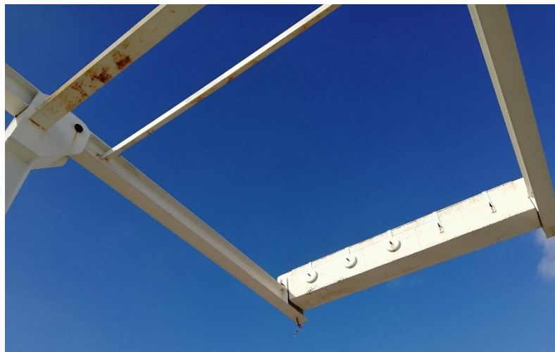
Figura 7.8 – Contrapeso da ponte móvel
