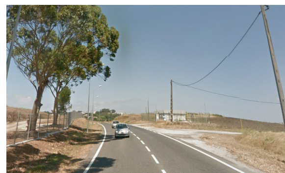
Foto. 4 | Vista dos cruzamentos da Rua da Fonte com dois acessos locais junto ao aterro de Vila Fria
