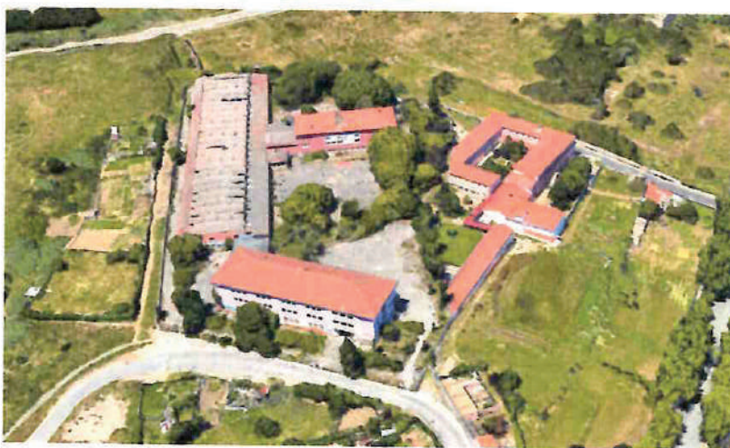
Escola Afonso Domingues e Casa de São Vicente
