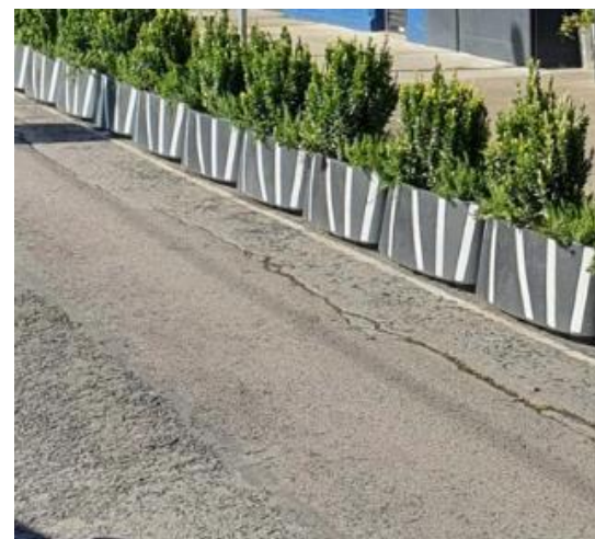
Floreiras (retentores de água) Fonte: Pittman
