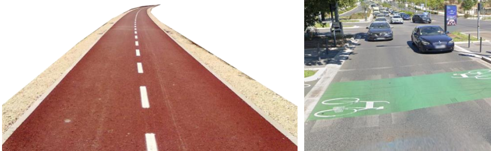
Figura 13 - Pintura 'slurry' sintético sobre macadame betuminoso para formalização de pista ciclável e aplicação de pintura termoplástica sobre betuminoso asfáltico em via existente, respetivamente
