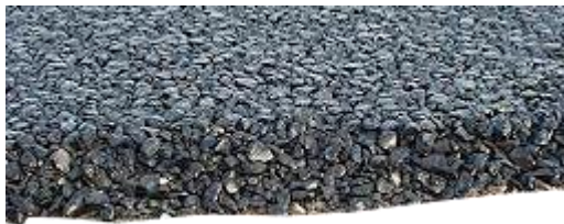
Figura 10 - Camada de 5cm de betão betuminoso de gravilha de basalto para circulação automóvel
