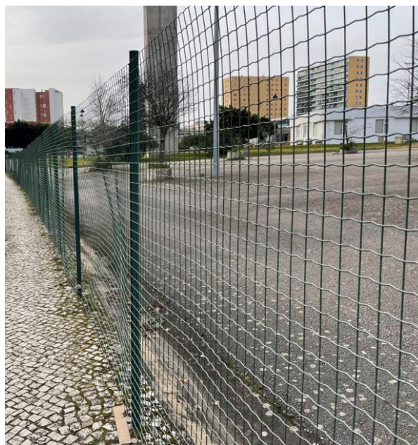
Figura 16 - Postes e rede de vedação existente
