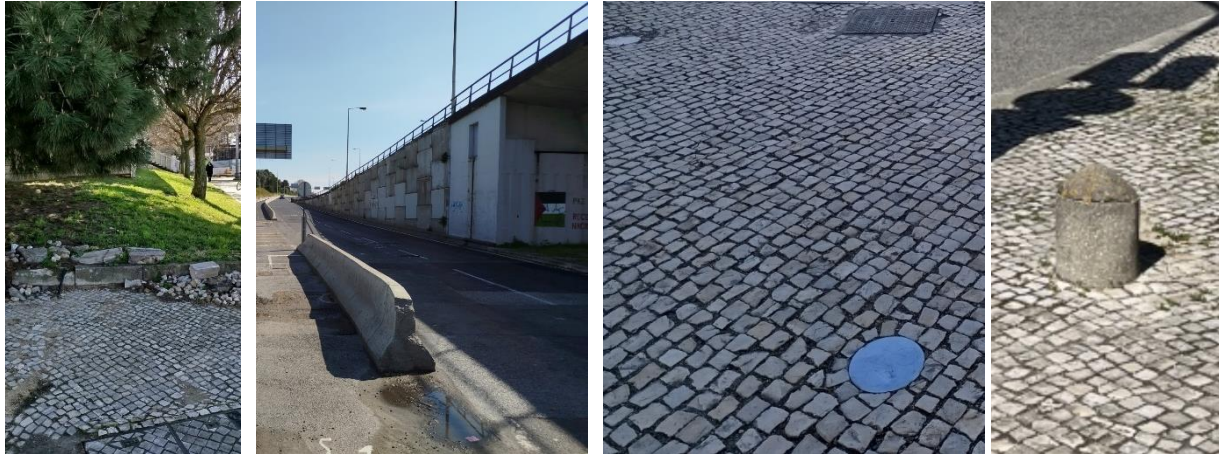
Figura 7 — Exemplos de elementos a remover/demolir
